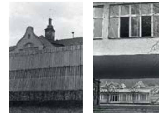
Der Pavillon beim Frohheim-Schulhaus
